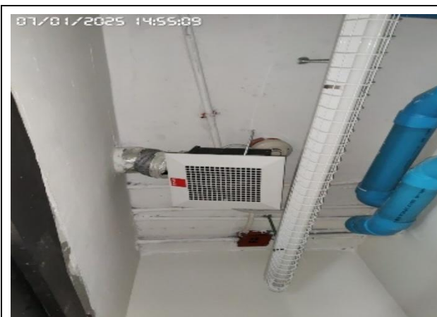
รูปที่ 3.3-6 พัดลมดูดอากาศในห้องขยะ
