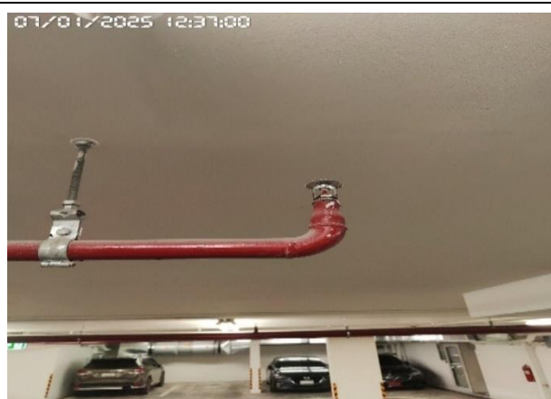
รูปที่ 3.8-9 ระบบหัวสปริงเกอร์ดับเพลิงที่ลานจอดรถ
