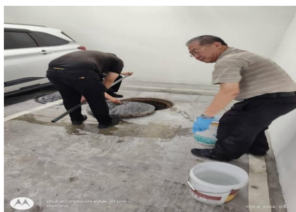
รูปที่ 1.6-3 เก็บตัวอย่างน้ำเสียเพื่อตรวจสอบ
